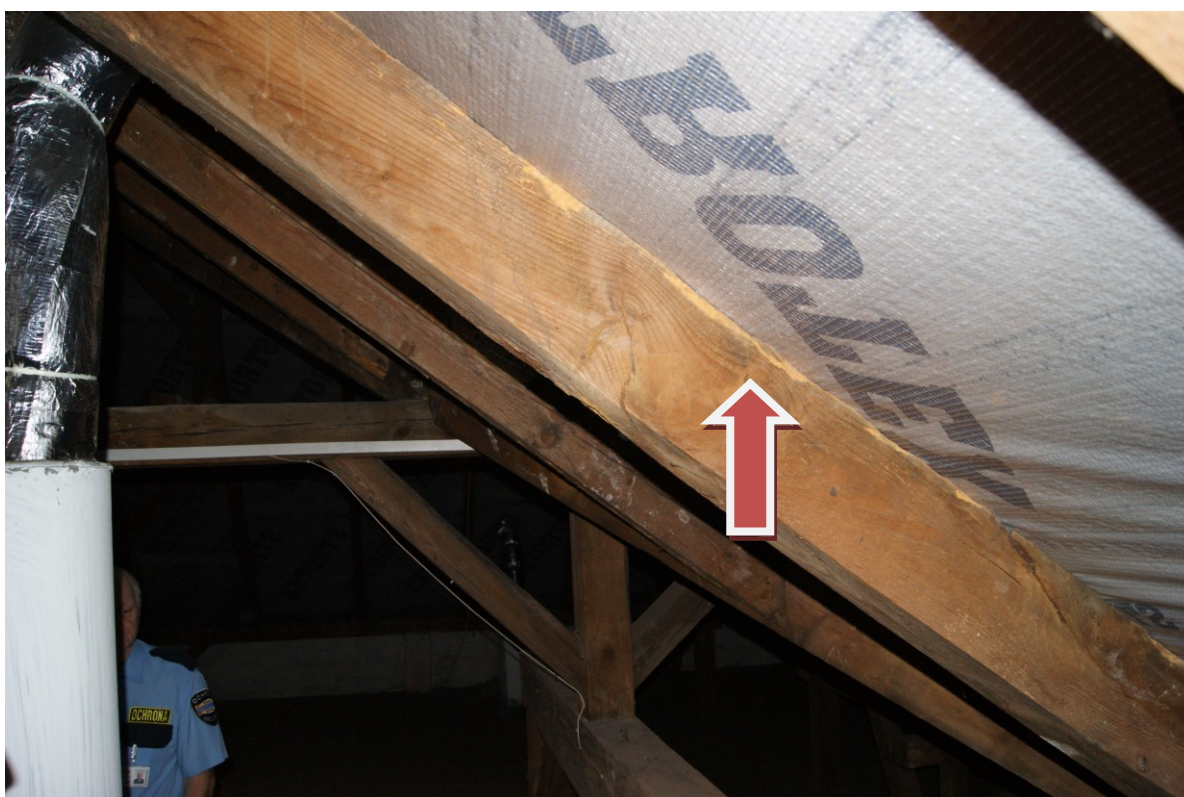
Zdjęcie Nr 8. Uszkodzenia krokwi wywołane występowaniem owadów.
