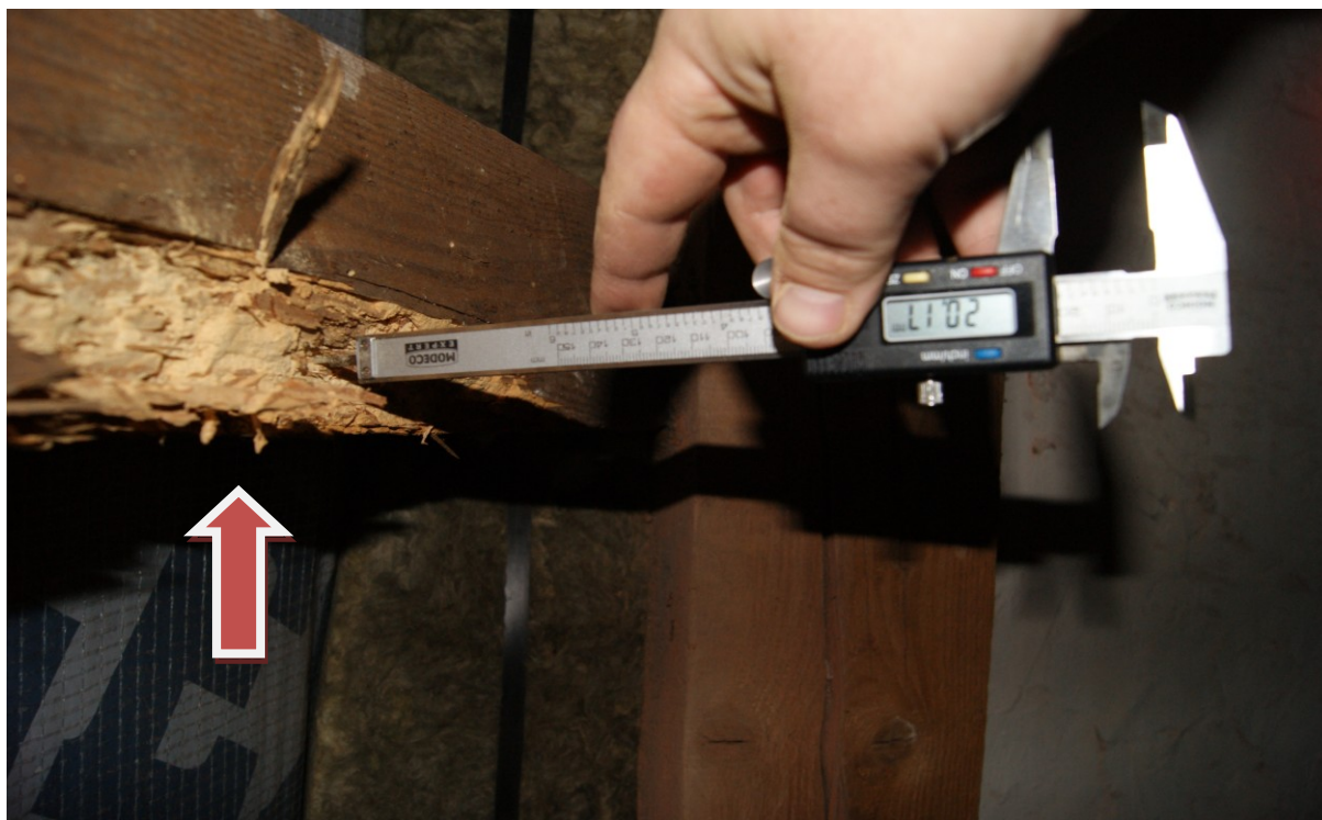
Zdjęcie Nr 13. Pomiar głębokości korozji ustroju - ścianka kolankowa.
