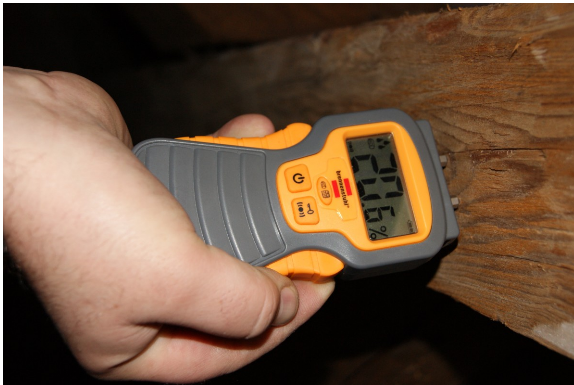
Zdjęcie Nr 18. Pomiar wilgotności konstrukcji dachu - 20,6 %.
