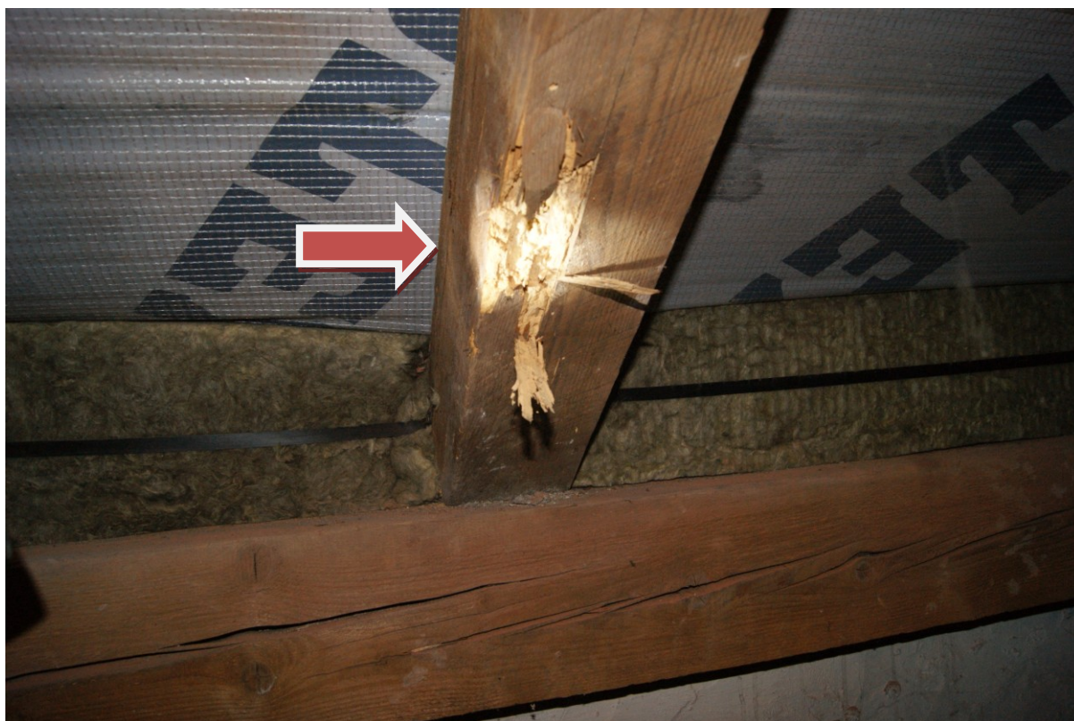
Zdjęcie Nr 12. Korozja ustroju nośnego więźby dachowej.
