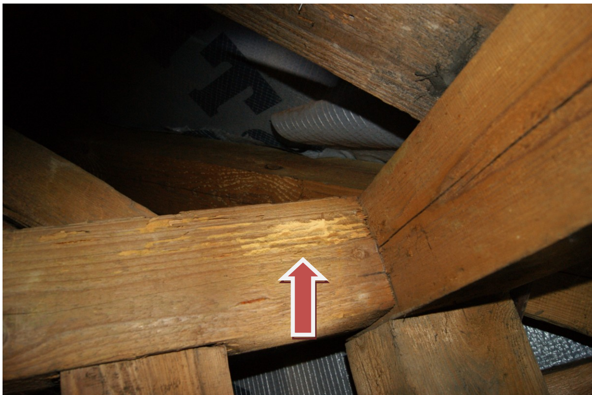
Zdjęcie Nr 1. Widoczne korytarze żerujących owadów.
