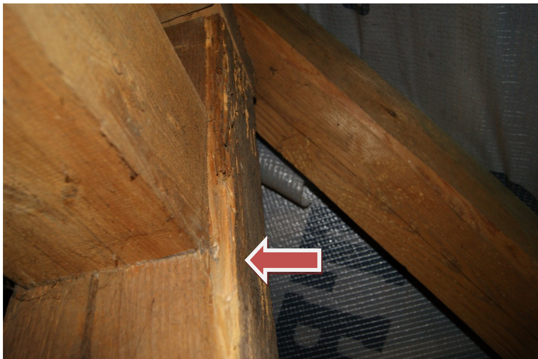
Zdjęcie Nr 3. Korozja wywołana żerowaniem owadów - słup wraz z krokwią.
