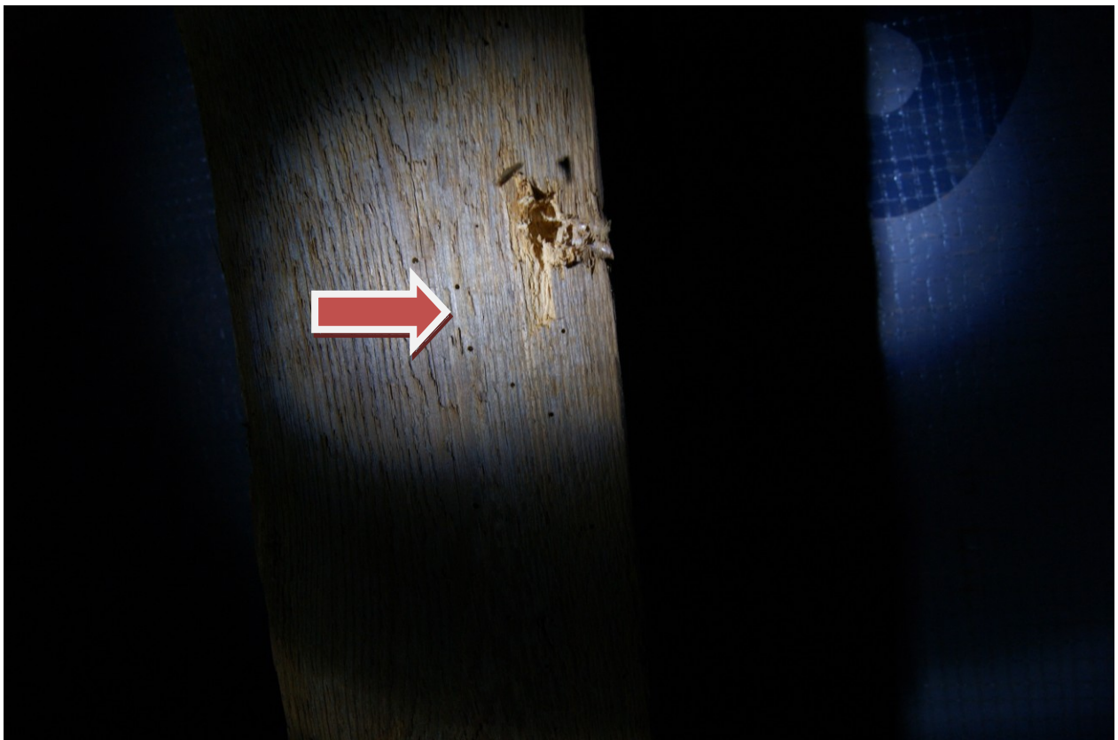
Zdjęcie Nr 6. Kilkumilimetrowe otwory wylotowe owadów.
