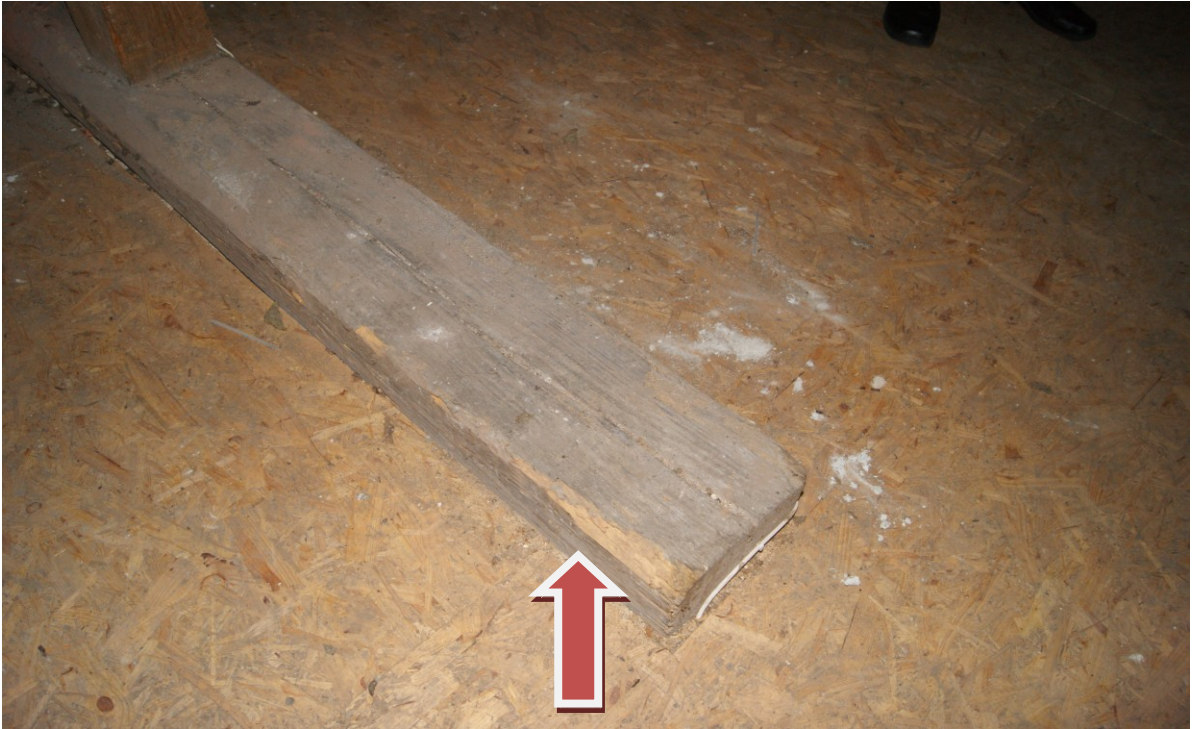
Zdjęcie Nr 5. Uszkodzona podwalina - przez żerujące owady.
