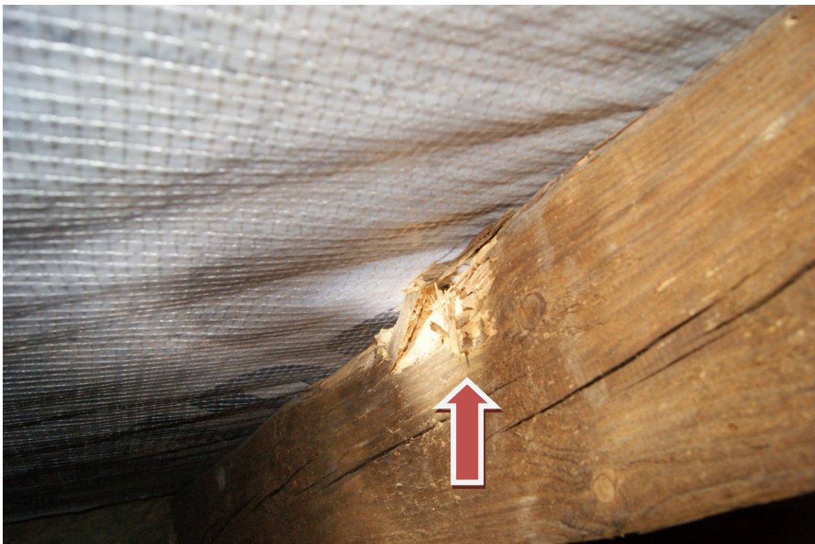
Zdjęcie Nr 9. Widoczne uszkodzenia krokwi.
