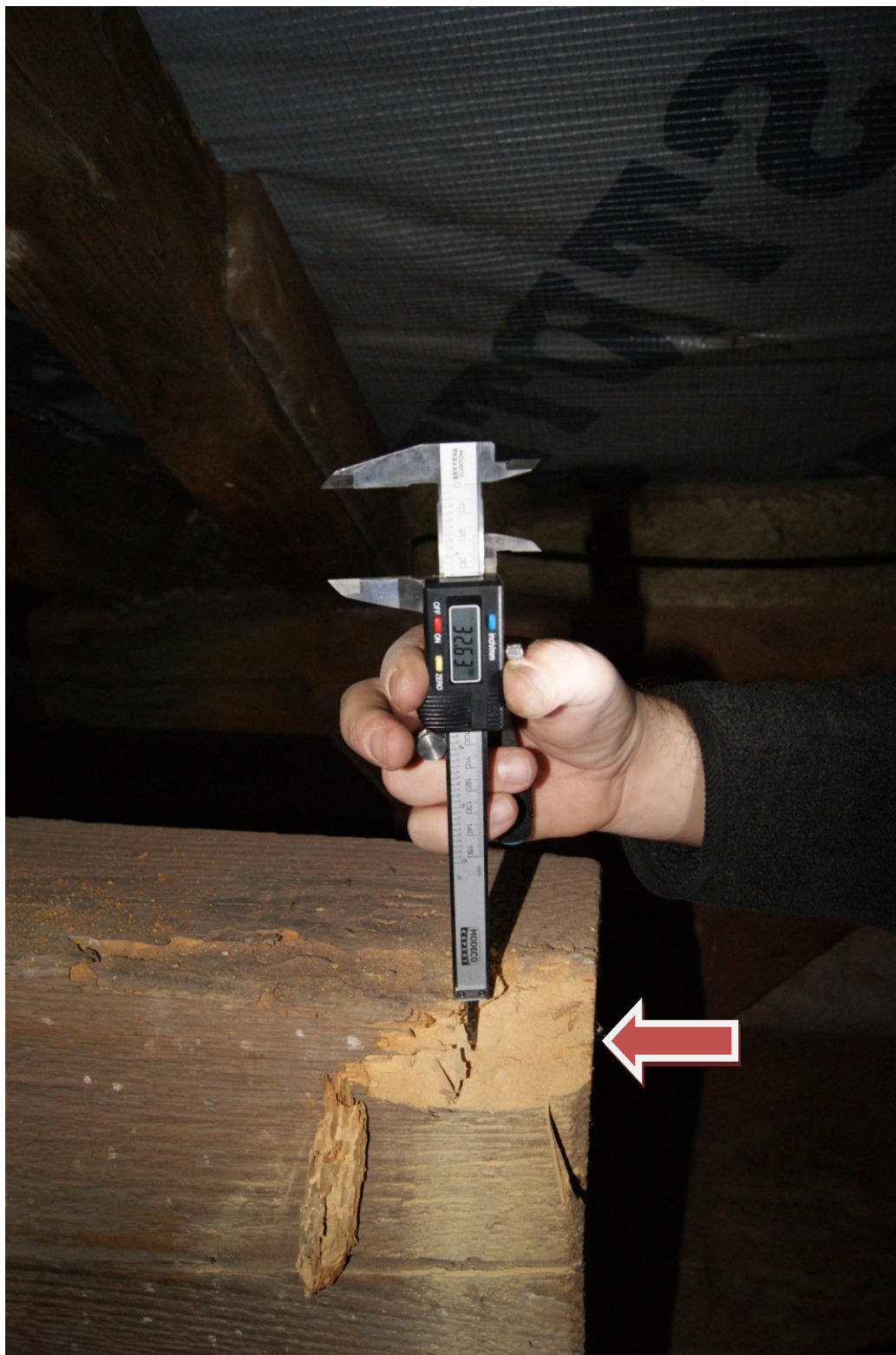
Zdjęcie Nr 15. Pomiar głębokości korozji ustroju - belka wsporcza.
