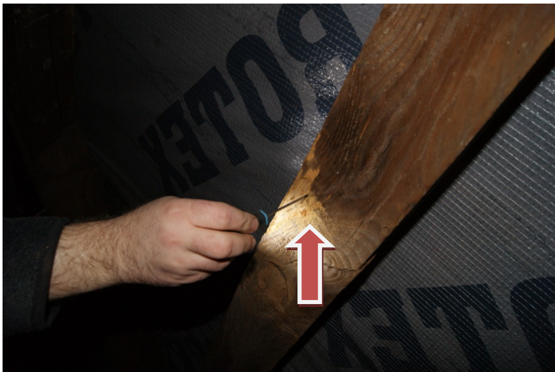
Zdjęcie Nr 7. Uszkodzenia krokwi wywołane występowaniem owadów.
