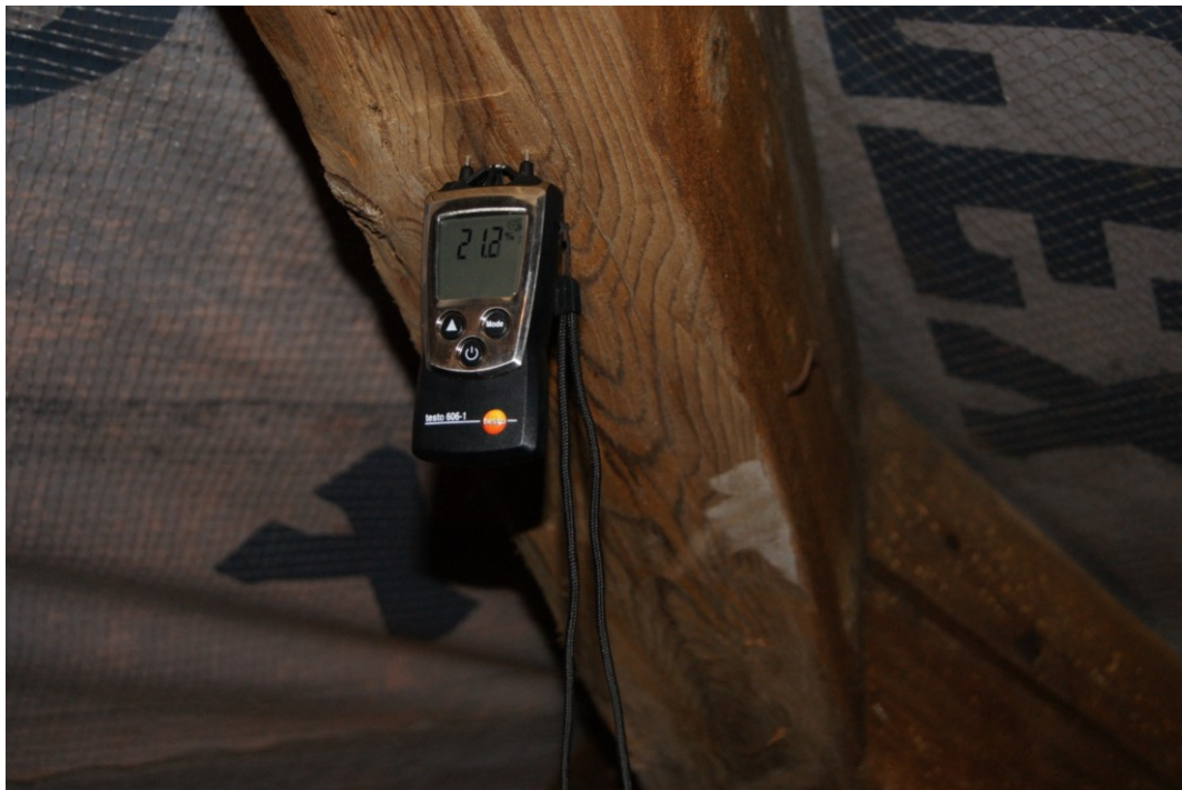
Zdjęcie Nr 16. Pomiar wilgotności konstrukcji dachu - 21,2 %.
