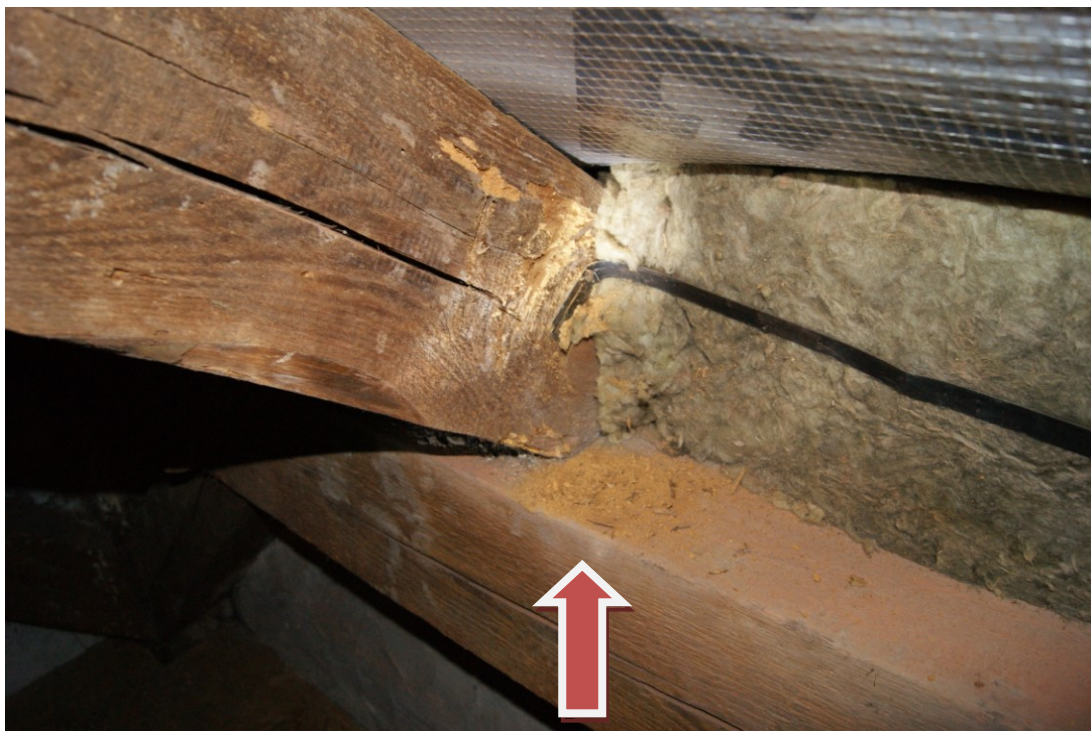
Zdjęcie Nr 11. Widok uszkodzonej krokwi i murłaty - mączka korozyjna.
