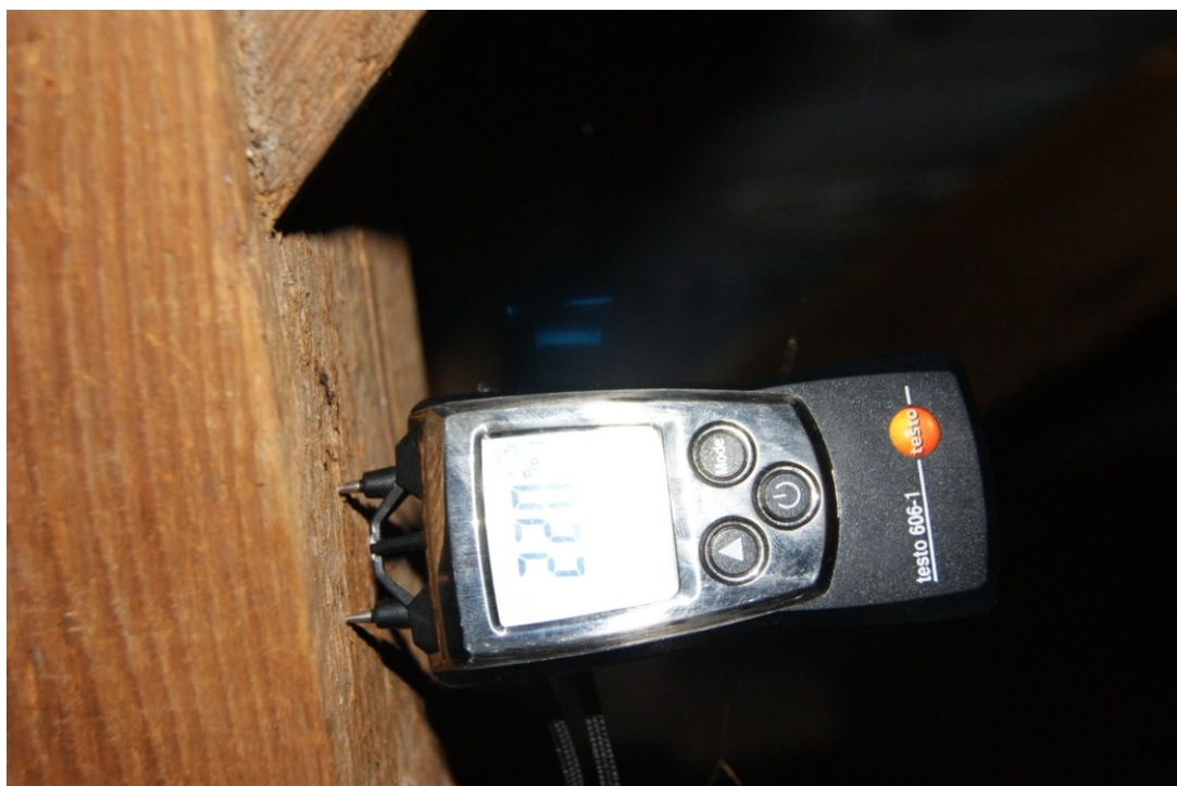
Zdjęcie Nr 17. Pomiar wilgotności konstrukcji dachu - 22,0 %.
