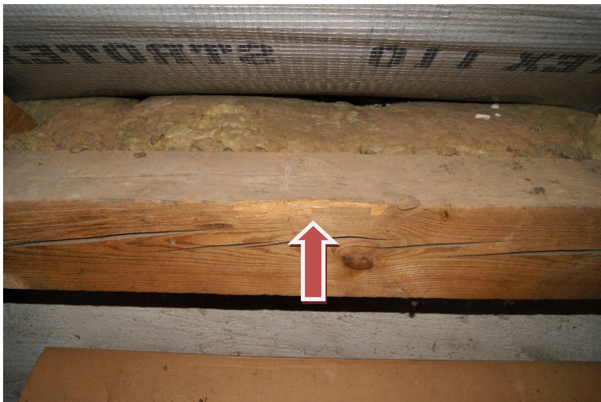
Zdjęcie Nr 4. Korozja - ściana kolankowa.
