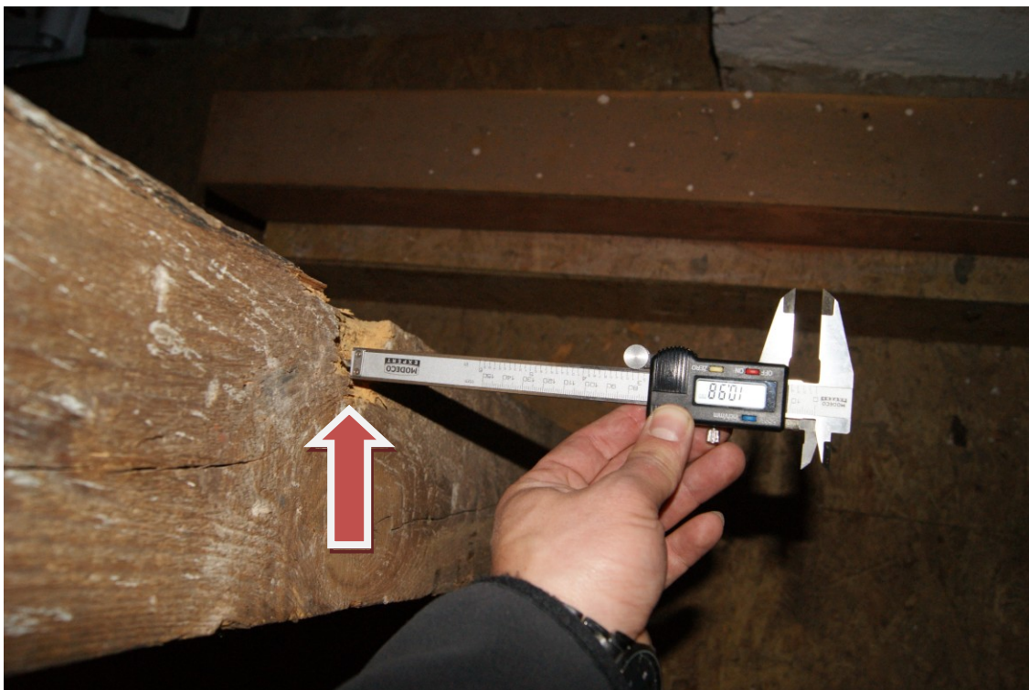
Zdjęcie Nr 14. Pomiar głębokości korozji ustroju - słup.
