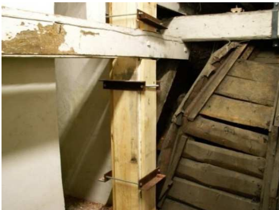
Zdjęcie Nr 10. Przykład scalenia uszkodzonego słupa metalowymi obejmami.
