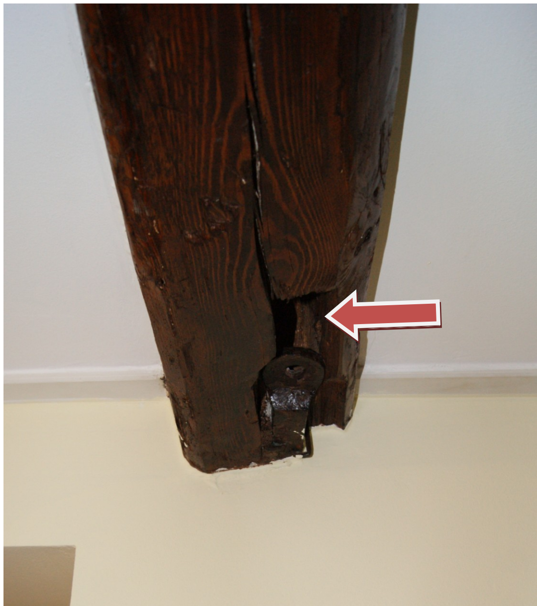
Zdjęcie Nr 2. Brakujące elementy więźby dachowej - prawdopodobnie miecze.
