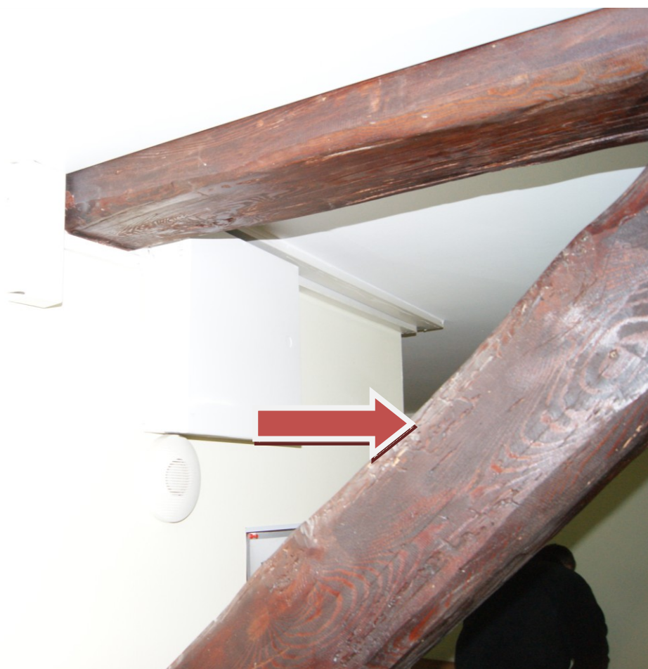
Zdjęcie Nr 1. Uszkodzenia belek wywołane infekcją owadami.
