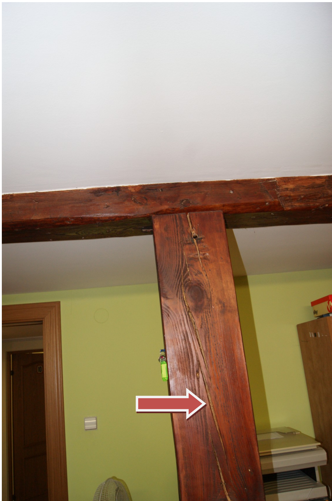
Zdjęcie Nr 6. Spękania - spowodowane skręceniem słupów.
