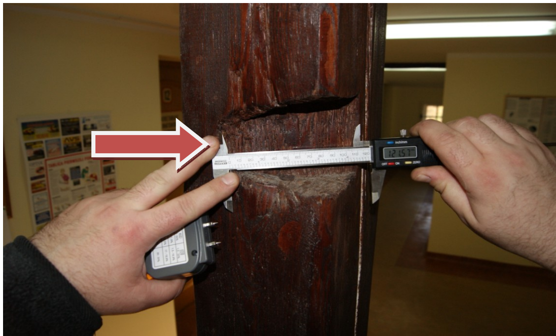
Zdjęcie Nr 7. Uszkodzenia mechaniczne słupów.
