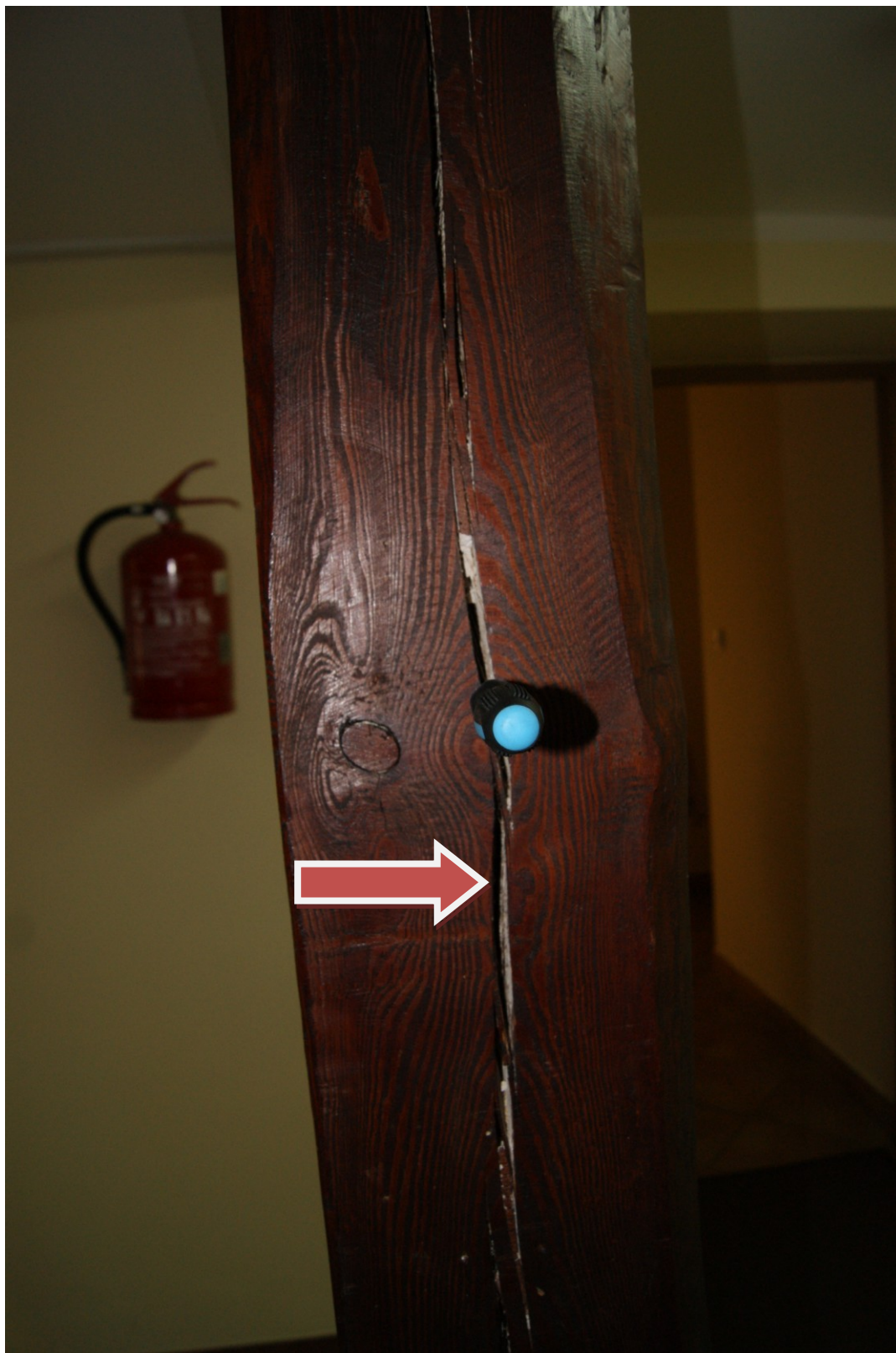
Zdjęcie Nr 3. Spękane elementy więźby dachowej - słupy.
