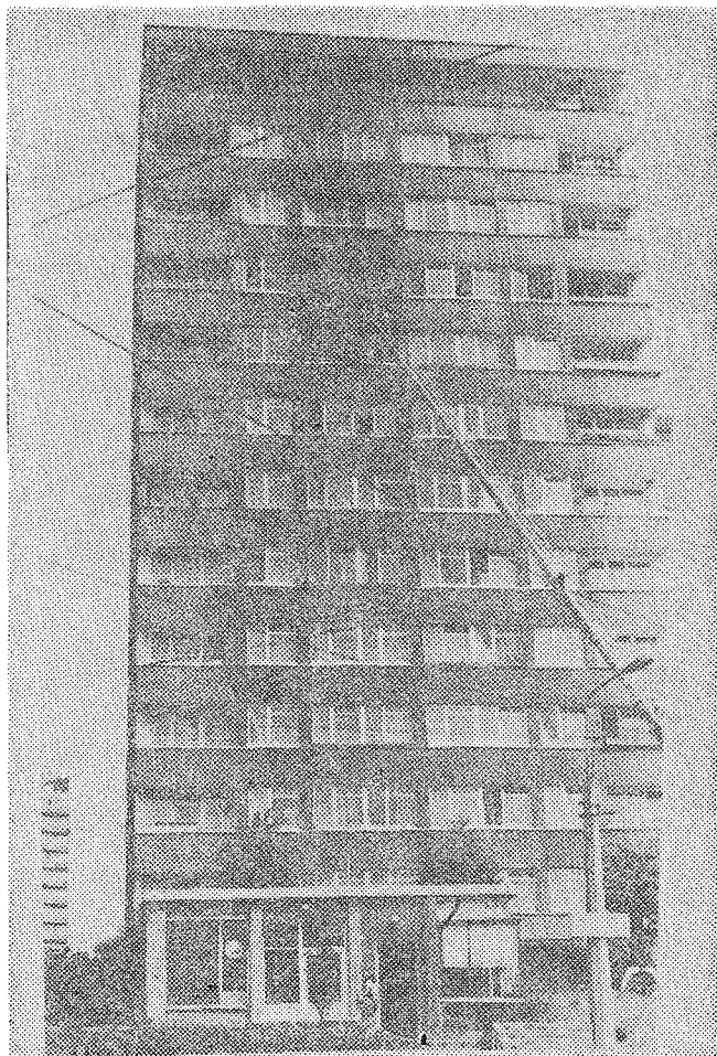
Ryc. 3. Budynek, w którym na VII piętrze nastąpił wybuch gazu
